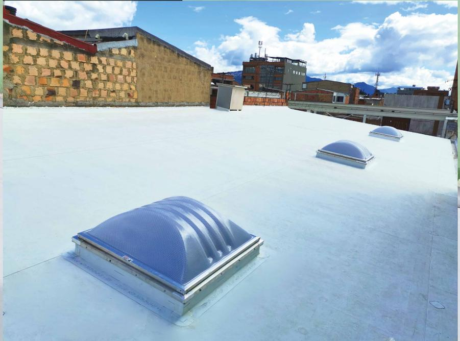
El sistema de cubierta con membrana TPO requiere poco o ningún mantenimiento cumpliendo con uno de los principales requerimientos del propietario. La iluminación natural fue reemplazada por claraboyas prismáticas, que proporcionan luz 100% difusa sin concentraciones de puntos calientes ni daños en la mercancía al interior. El sello de las claraboyas es estanco y hermético que elimina los riesgos de gotera ocasionados por el sistema de iluminación anterior.
