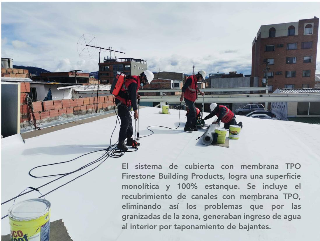
El sistema de cubierta con membrana TPO Firestone Building Products, logra una superficie monolítica y 100% estanca. Se incluye el recubrimiento de canales con membrana TPO, eliminando así los problemas que por las granizadas de la zona, generaban ingreso de agua al interior por taponamiento de bajantes.
