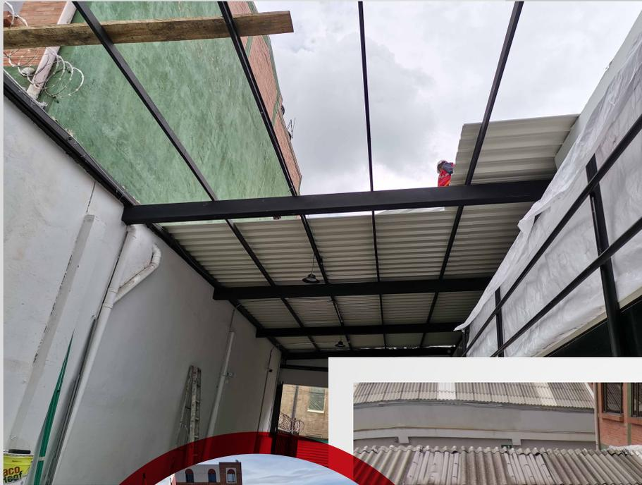
El equipo técnico de Sukot Roofing S.A.S., tras revisar una inspección técnica para el diagnóstico de la cubierta actual, propone el cambio de cubierta por una cubierta deck con membrana TPO, teniendo en cuenta que la cubierta existente es teja de fibrocemento que deberá por ley ser cambiada en los próximos años.
